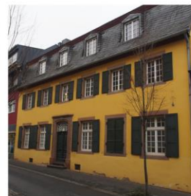
mittlerer Gebäudezustand, Kölnstraße. Foto RaumPlan
