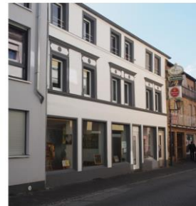
dreigeschossiges Gebäude, Kölnstraße, RaumPlan
