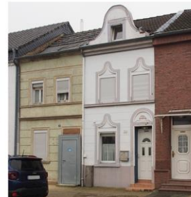
Gebäude vor 1945, Von-Lutzenberger-Straße, Foto RaumPlan
